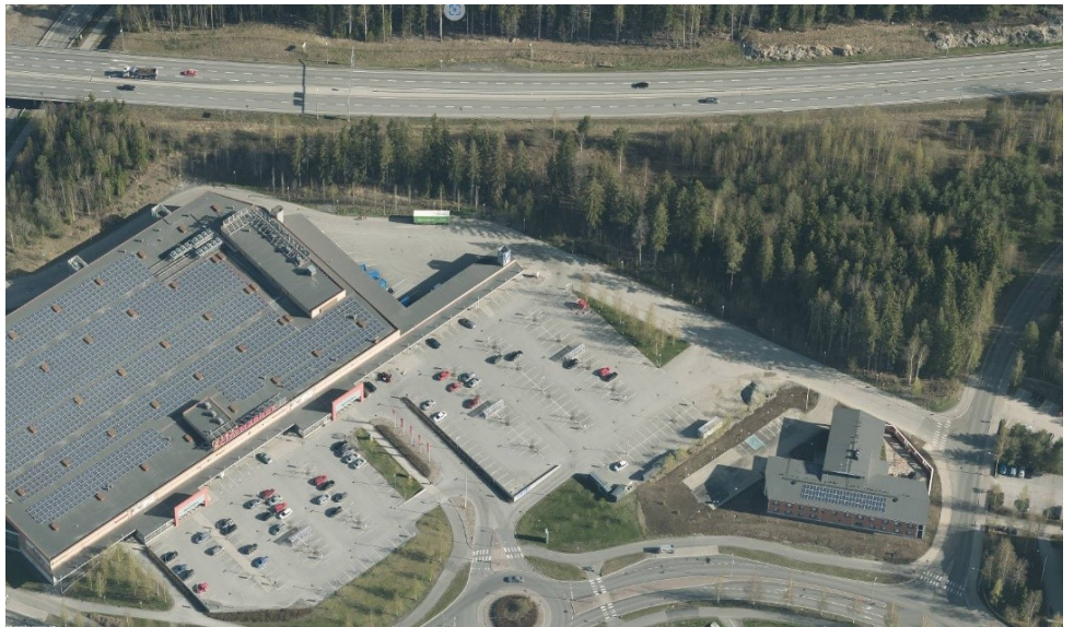
Kuva 6: Viistoilmakuva suunnittelualueesta kohti pohjoista (Blom, 2021).
